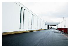
守山工場外観
